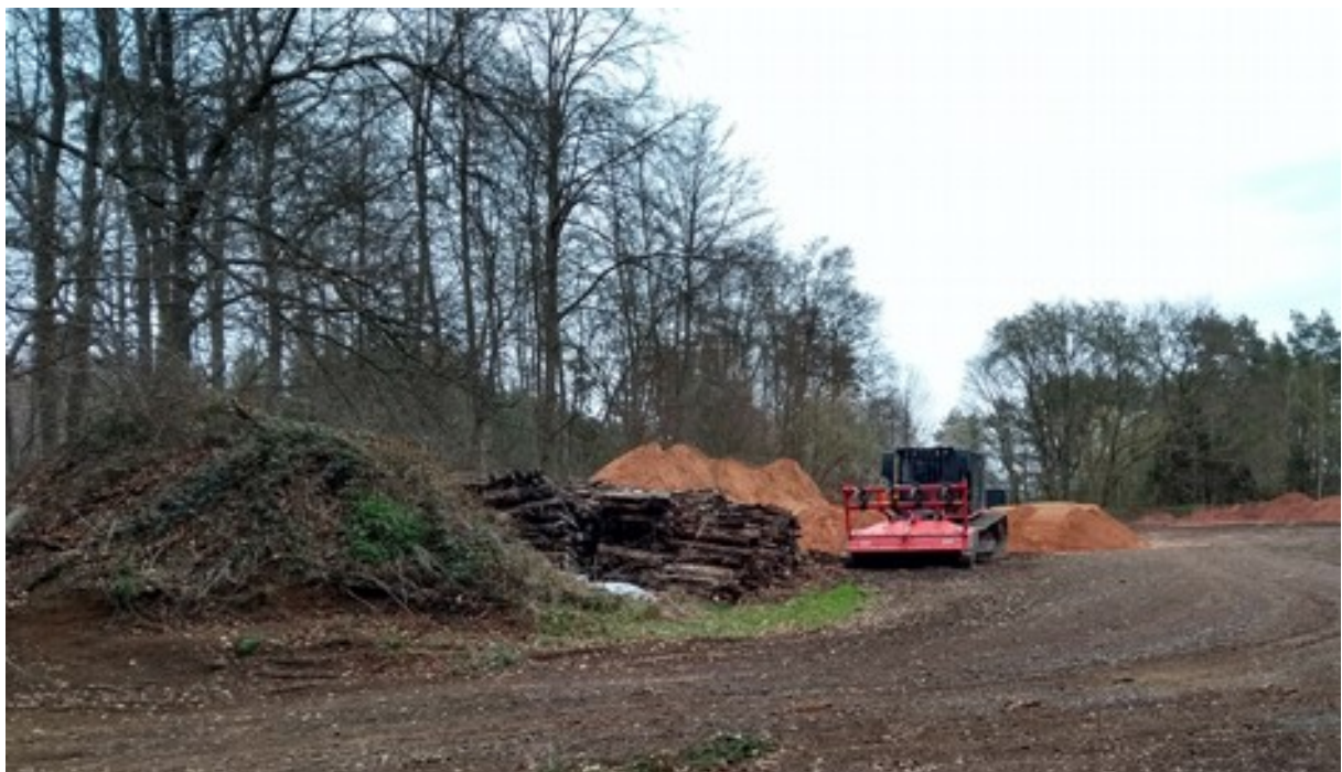
Foto 2 zu Baustofflager im Wald, Bereich der Parzelle 3428 und angrenzende
