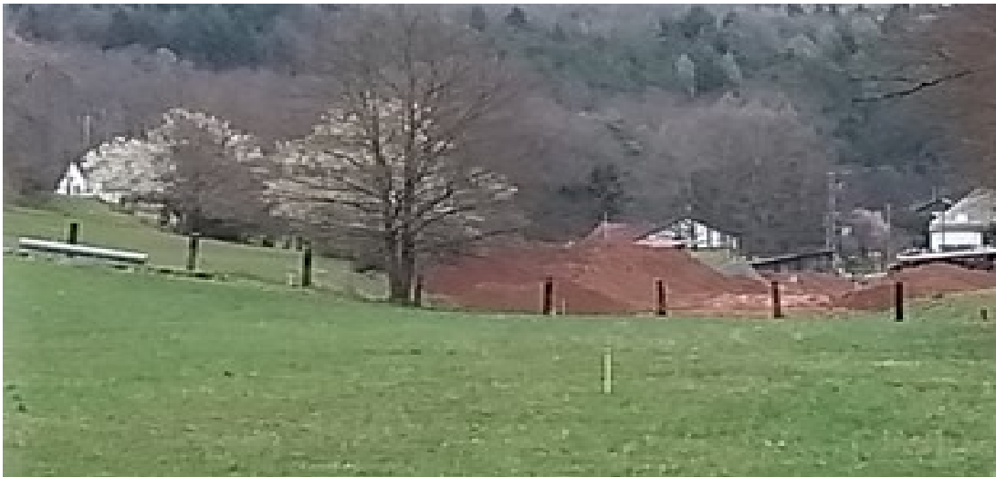
Foto Lagerplatz F. Auffüllung Stand April 2021
